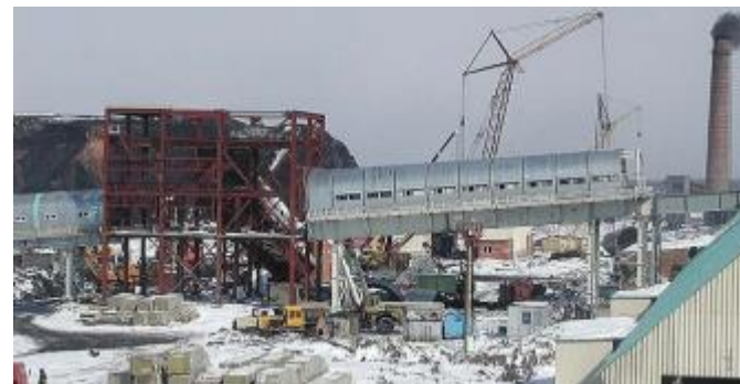
ФАБРИКА ПО ПЕРЕРАБОТКЕ КОКСУЮЩЕГОСЯ УГЛЯ ЦОФ «СЕВЕРНАЯ»
